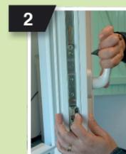
Actionner l'anti fausse manoeuvre vers soi, (main gauche).
